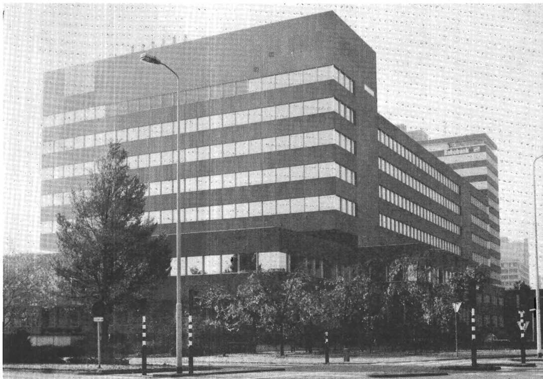
Gesloten ramen, zoals ook het Rabo-gebouw in Eindhoven heeft, kunnen tot veel klachten leiden.
